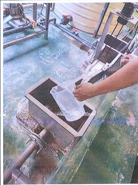
车间废水处理后采样口DW001
