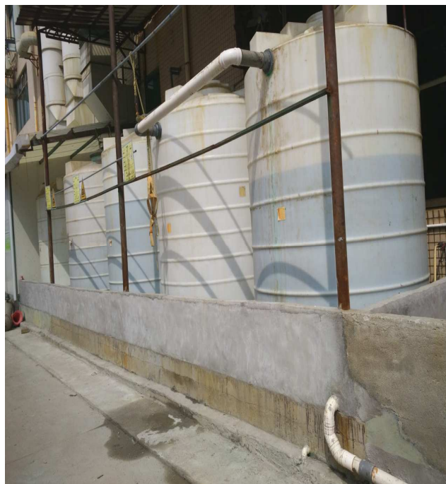
D 加高储罐围堰
