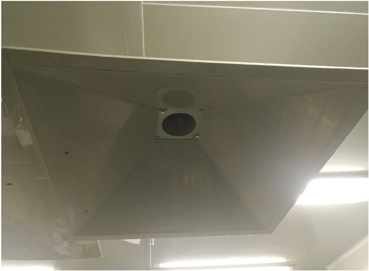
图 5-7 改造后废气收集图 1
