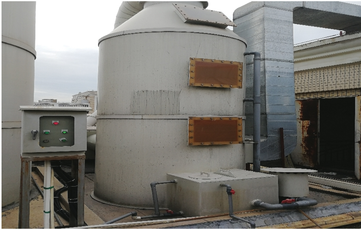
图 5-9 改造后废气喷淋塔生物处理法图
